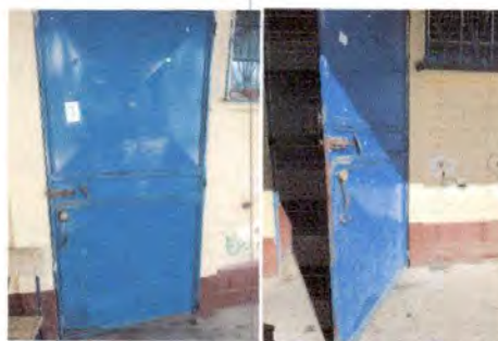
Foto 6: Modulo 3 Sustitución de puertas
