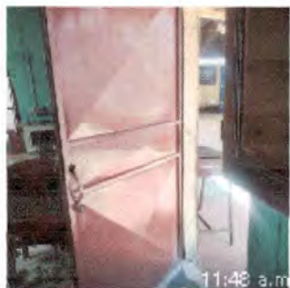
Foto 3: Modulo 1 Sustitución de puertas
