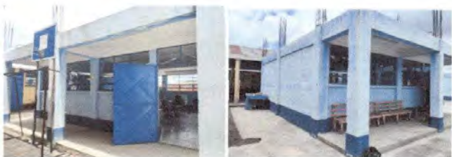
Foto 5: Modulo 3 Pntura en muros exteriores de 2 aulas
