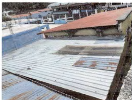
Foto 1: Modulo 1 Sustitución lamina por lamina toquelada de alucinc mas estructura
