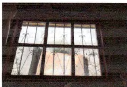
Foto 5: Modulo 1 Sustitución de ventanas de madera por metal y vidrio
