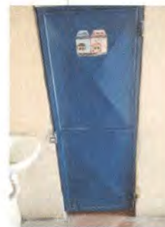
Foto 2: Modulo 3 Sustitución de puerta de servicio sanitario
