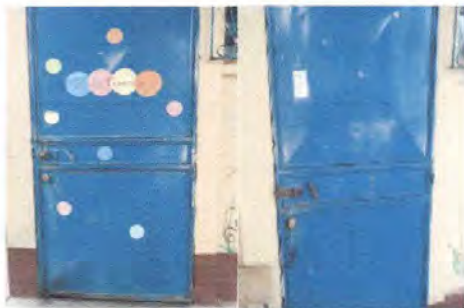
Foto 1: Modulo 3 Sustitución de puertas
