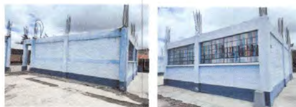
Foto 6: Modulo 3 Pntura en muros exteriores de 2 aulas
