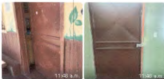
Foto 2: Modulo 1 Sustitución de puertas
