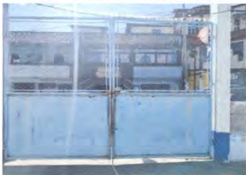
Foto1: Entrada Principal Modulo 1 Sustrución de porton principal
